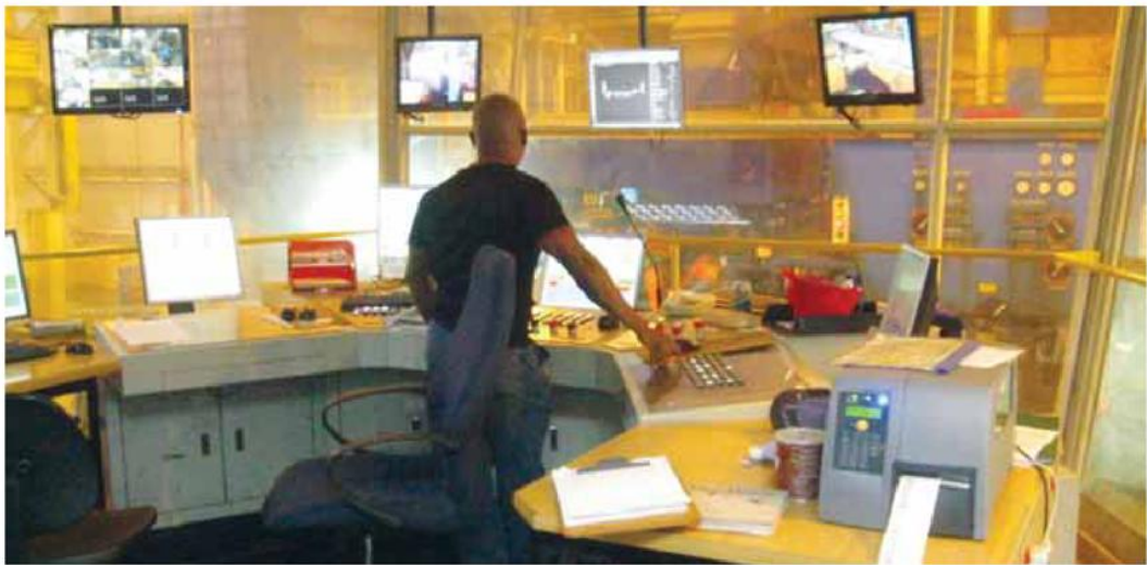
图 3-9 双层玻璃控制室
